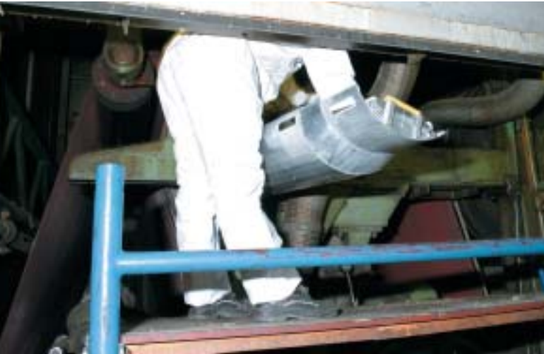
Bild 2: Einführen der Rettungsschale durch das Mannloch
