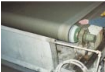
Bild 4: Auch diese Auflaufstelle ist in Reichweite. Das vorhandene maschinenseitige Geländer bietet keinen ausreichenden Schutz.
