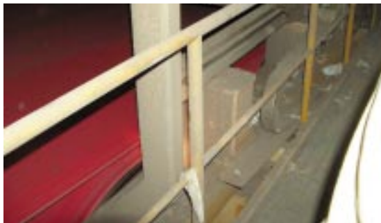
Durch dieses Geländer stieg der Papiermacher in die laufende Maschine ein.
