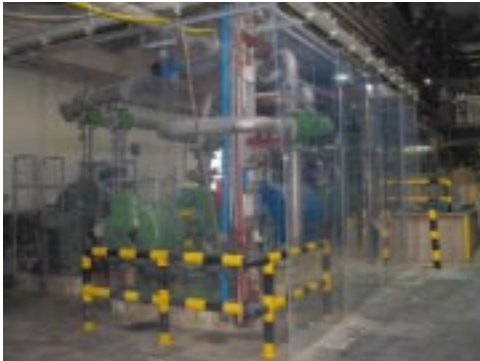
Die Einhausung der Mahlstraße
