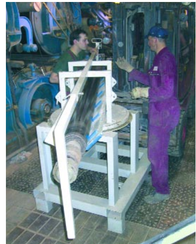
Die neue Walze vor dem Anheben auf die Einbauposition, um 45° gedreht und durch die verstellbaren Anschläge gesichert.
