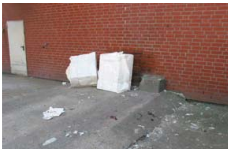
Bild 2: Der aus seinem Stapler ausgestiegene Fahrer wurde von zwei jeweils über 200 kg schweren Zellstoffballen getroffen.
