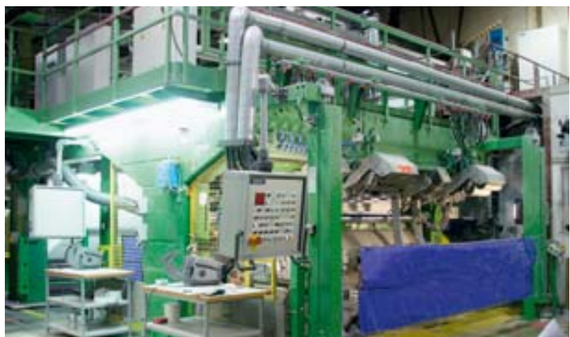
Bild 3: VariRoll nach dem Umbau, die trennende Schutzeinrichtung (blau) wird zum Rollenwechsel nach oben gefahren.
