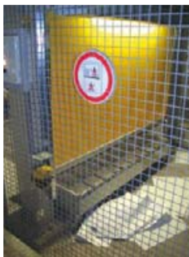
Moderne Lösung zur Sicherung der Quetschgefahren unterhalb der Hubarbeitsbühne am Querschneider, die das Ein- und Ausschleusen von Paletten erlaubt: Eine Kombination aus Umzäunung, Rolltor und Laserscanner
