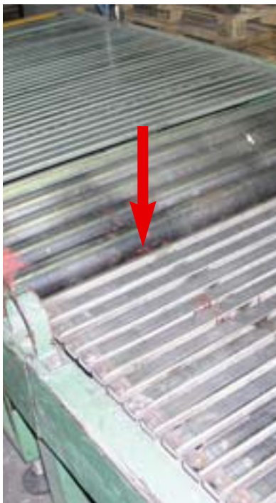
Pfeil: Übergang zwischen Lamellenband (rechts) und nicht angetriebener Rolle
