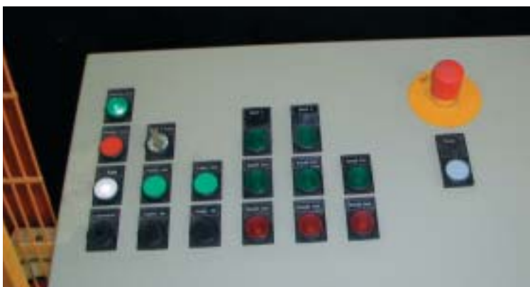
Bild 5: Günstige Anordnung eines Not-Aus-Stellteiles am Steuerstand einer Förderstrecke für Papierrollen, sodass eine unbeabsichtigte Betätigung unwahrscheinlich ist.
