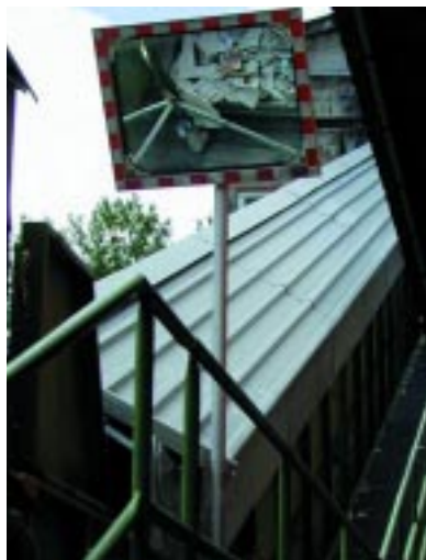
Bild 5 Durch einen Spiegel lässt sich die Aufgabestelle am Altpapierband einsehen. Die bei Rückwärtslauf entstehende Einzugstelle ist vom Bedienpult aus einsehbar.
